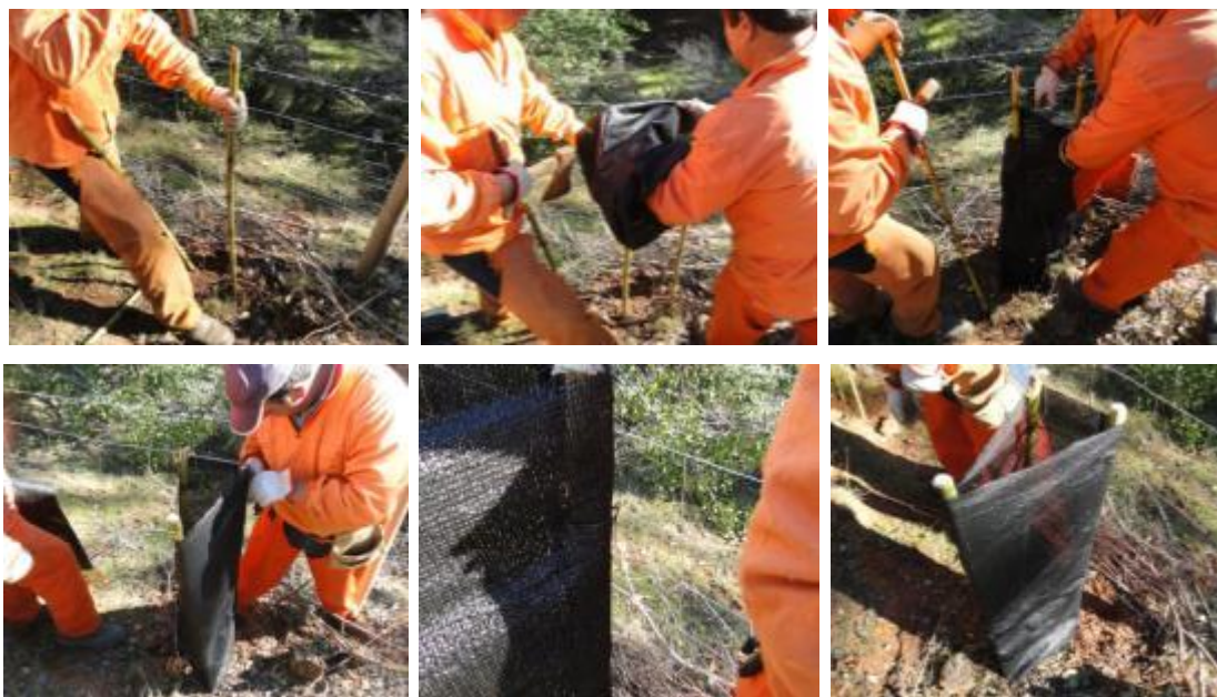
Figura 19. Secuencia de acciones para las instalación de mallas de protección artificial.
