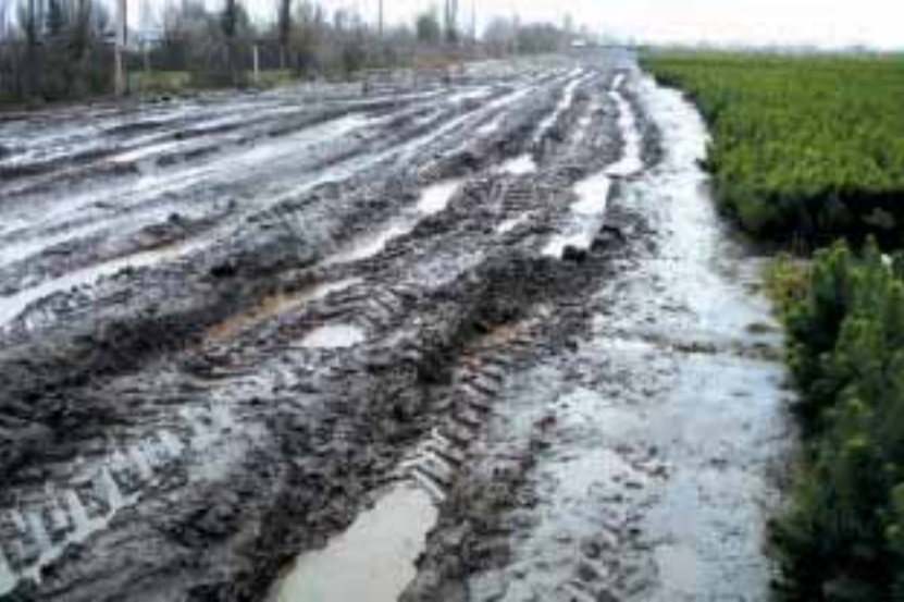
Camino no estabilizado en suelo arcilloso
