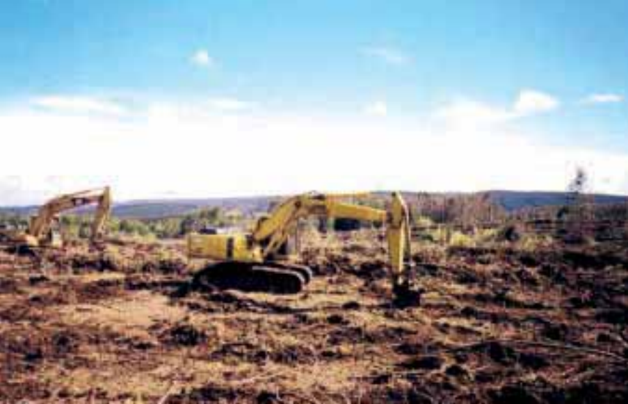
Ordenación del desecho y la confección de casillas con excavadora
