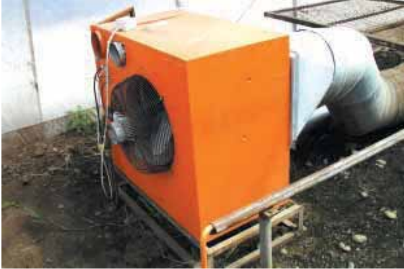
Equipo de calefacción a gas para el control de la temperatura en el interior del invernadero (Vivero Proplantas, 2000)
